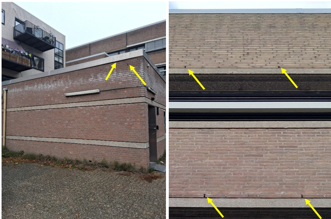
Figuur 5. Voorbeelden van openingen langs dakranden en open stootvoegen die toegang bieden tot de spouwruidtes (gele pijlen).
