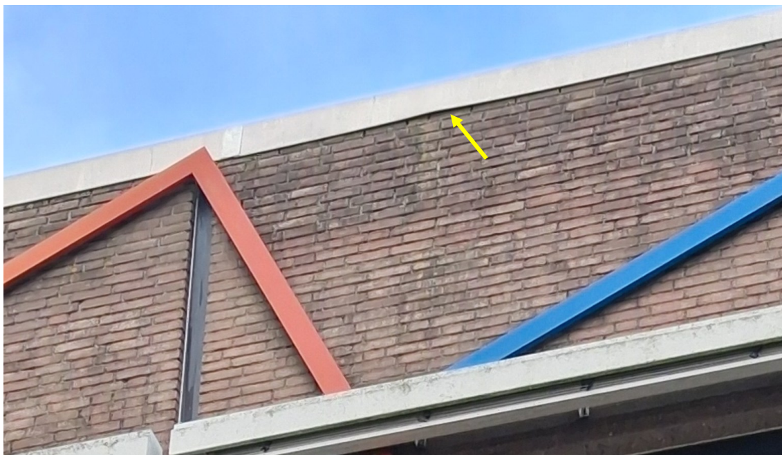
Figuur 7. Voorbeeld van een opening langs een dakrand die breed genoeg is als nestruimte voor de gierzwaluw.
