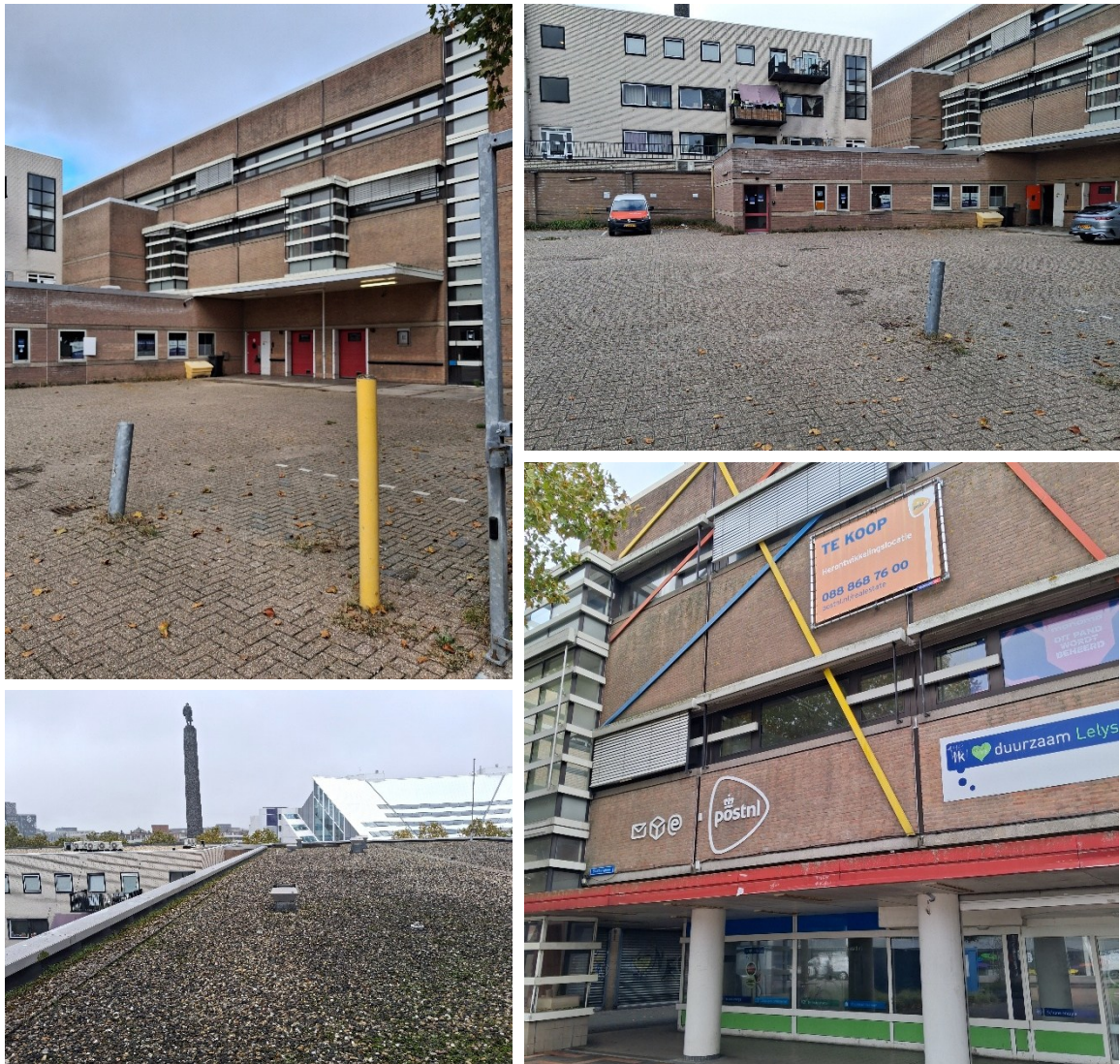
Figuur 2. Binnenplaats en uitzicht op het zuiden van het gebouw (linksboven), binnenplaats en uitzicht op het lagere aangebouwde gedeelte (rechtsboven), dak van het hoge gebouwgedeelte met uitzicht op de Zuil van Lely (linksonder) en de westzijde van de bebouwing (rechtsonder).
