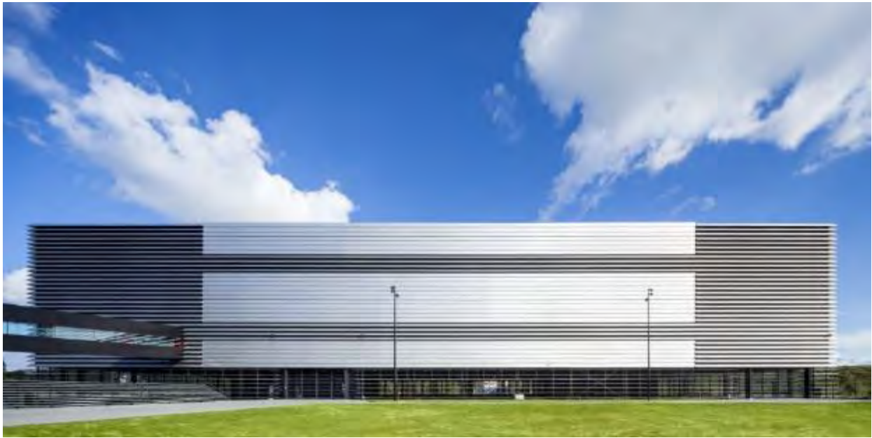
Figuur 2.1 Referentiebeeld datacenter (bron: Mulderblauw)
