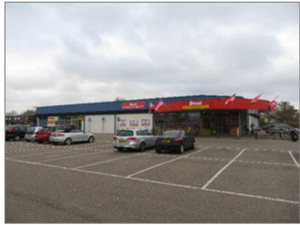
Afbeelding 2.2 De parkeerplaats en supermarkt gezien vanuit het zuiden.
