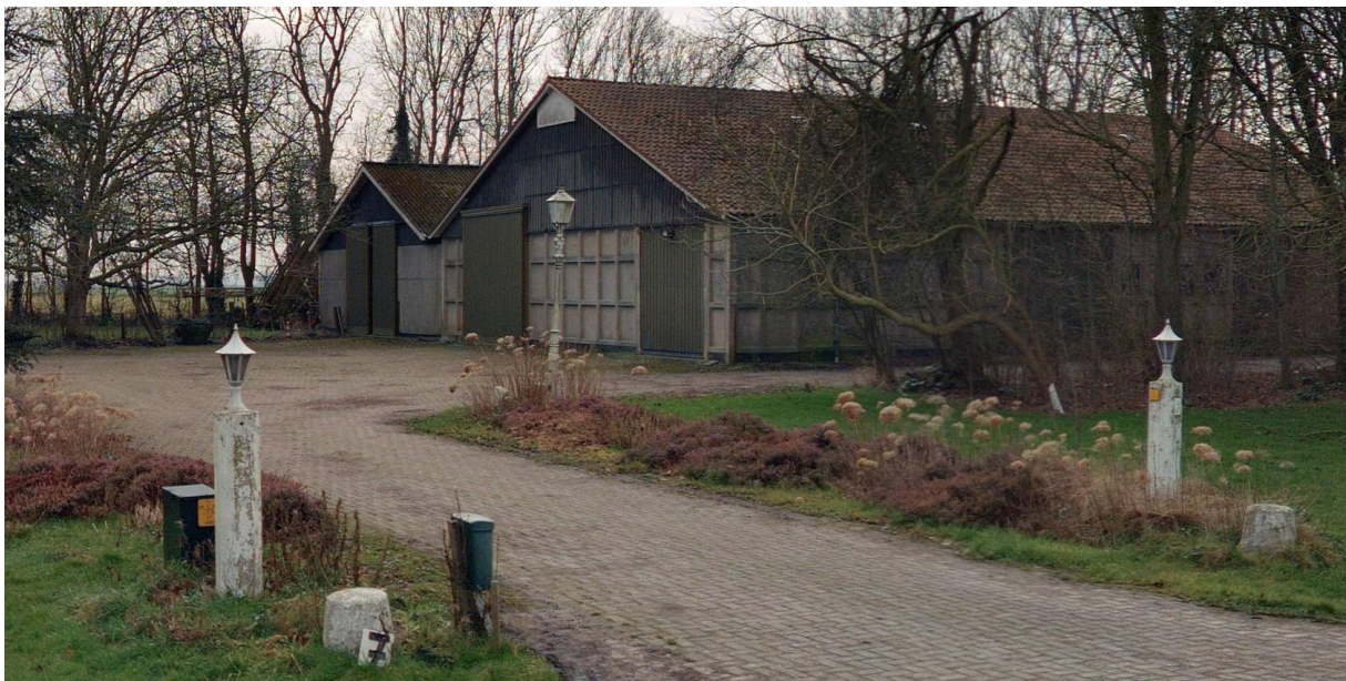
Figuur 8: Schokbetonschuur in kwestie.
